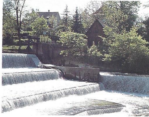
Abb.43: Das Wühr Neuwelt mit dem Einleitungsbauwerk St. Alban-Teich. Mai 1995.
